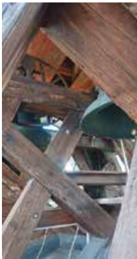
Historischer Holzglockenstuhl aus Kiefer im Bestand
